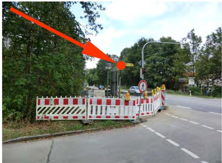
**Bemerkungen:** bestehende Alt-Wegweisung (gelb) im Knotenbereich entfernen; bestehenden Pfosten um ca. 1,0 m nach Südwesten versetzen
