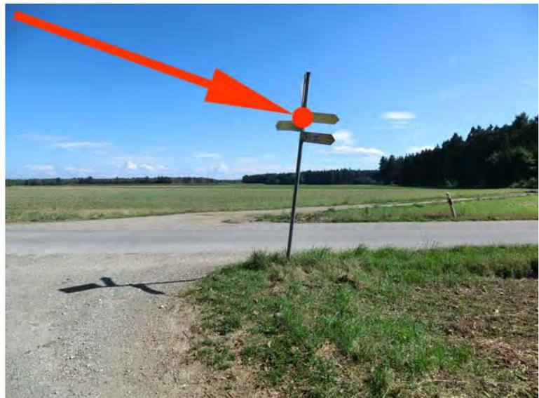
**Bemerkungen:** bestehende Alt-Wegweisung (gelb) im Knotenbereich entfernen; Montageart "Seite an Pfeil" bei Pfeilwegweiser Ri. Osten (Purfing) beachten; ggf. Rohrpfosten begradigen
